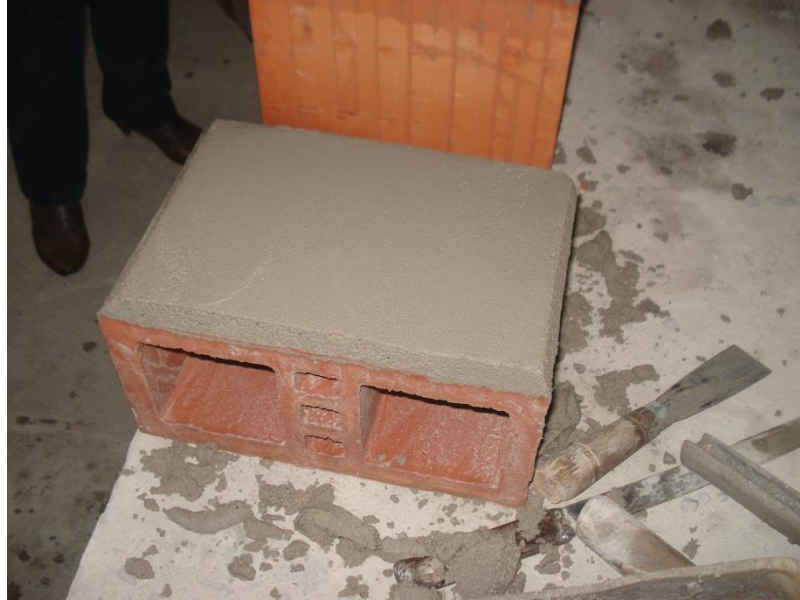
Figura 13: Assentamento da argamassa para ensaio de aderência.
