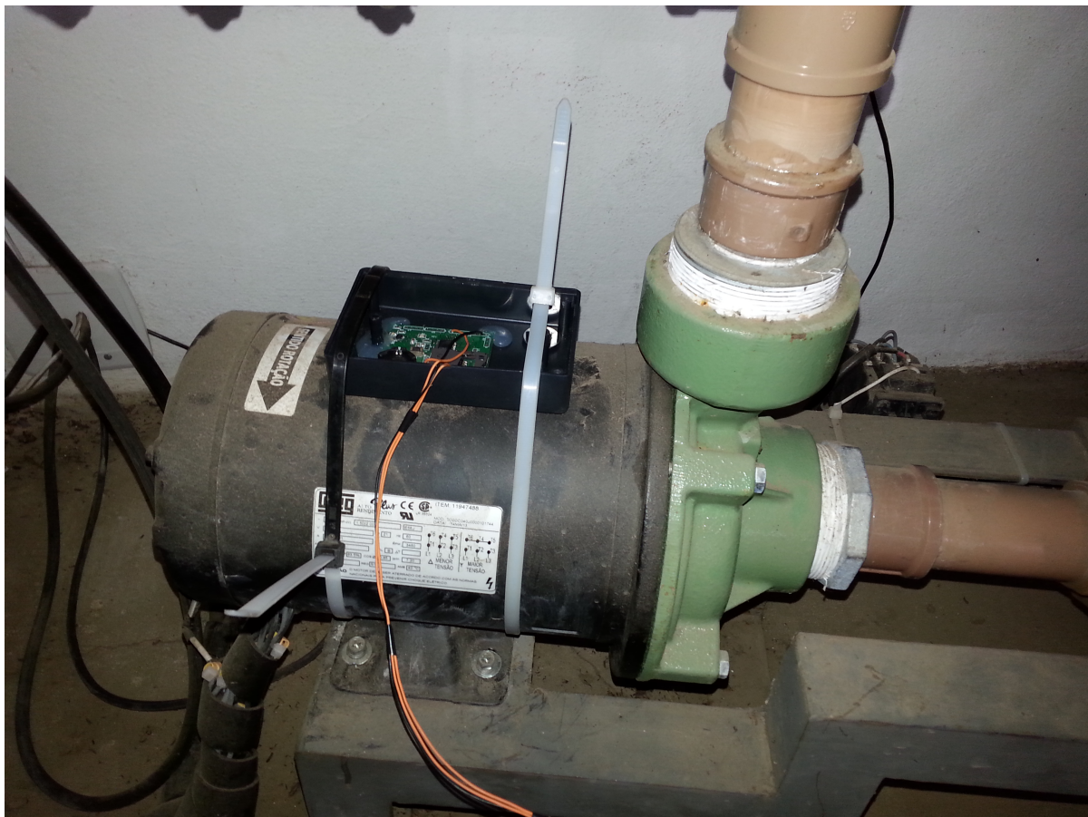
Figura 35: Data logger fixado ao motor.
