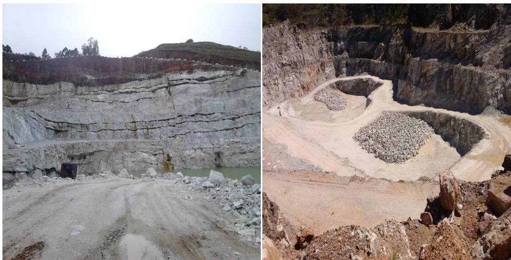
(a) Retaludamento empresa B.
