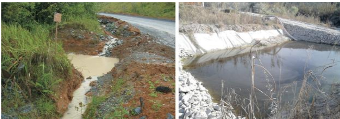
(a) vala de drenagem.
